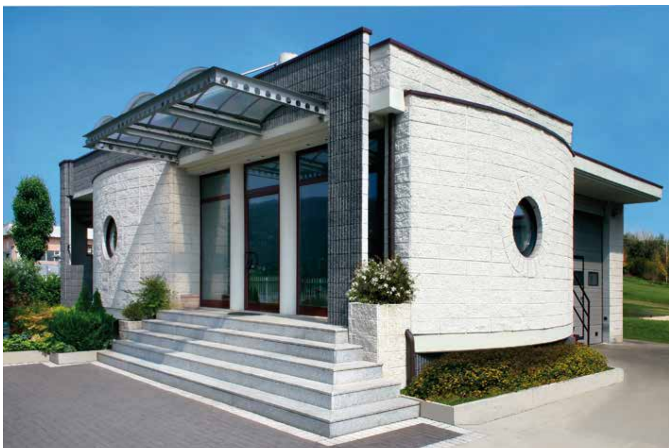
Nuvolento - BS • Palazzina Uffici Bodei • Architettonico Splittato Bianco Botticino - Architettonico Rigato Antracite
