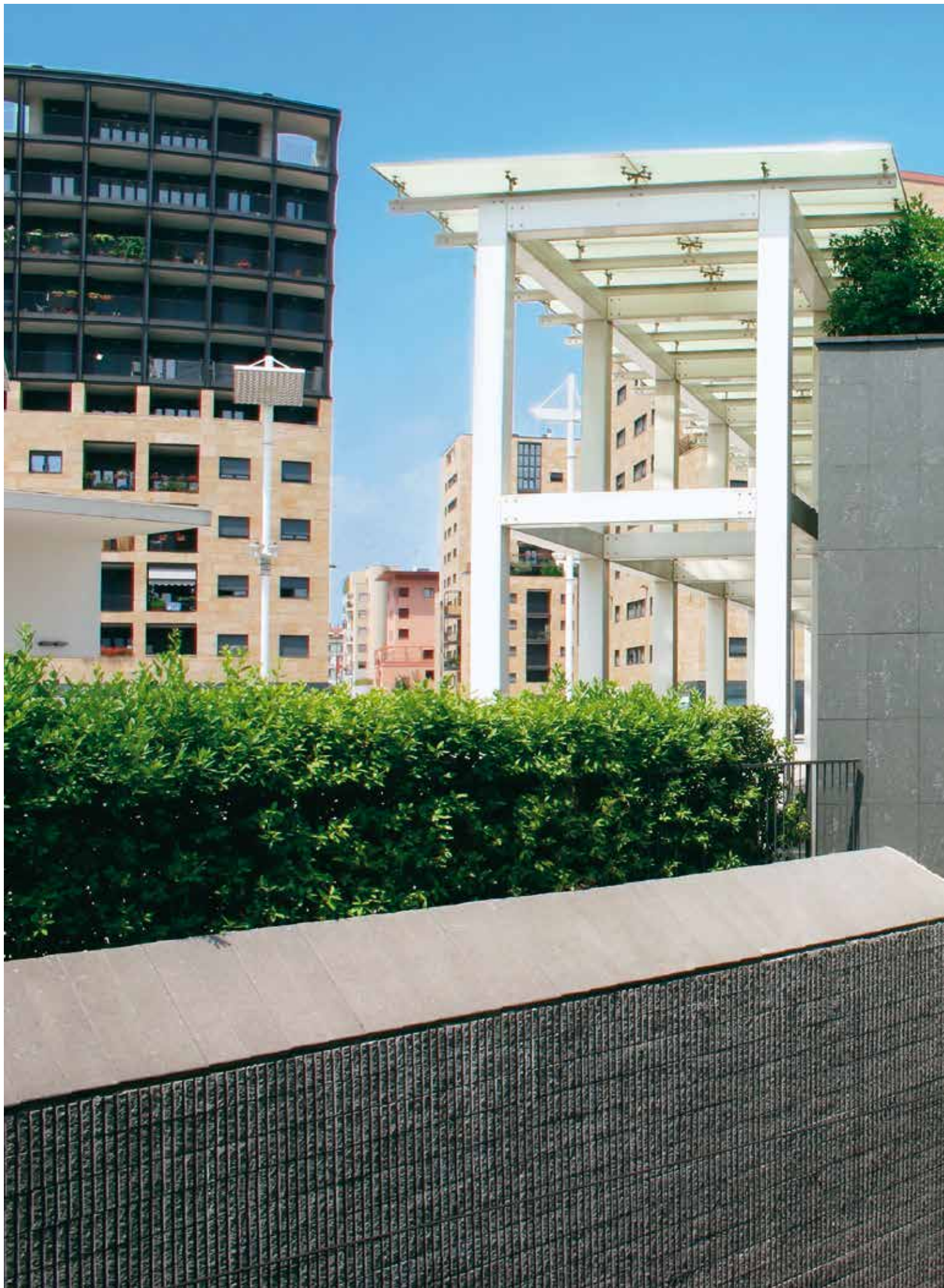
Milano • Tunnel Stazione Ferroviaria di Milano Bicocca • Architettico Rigato Antracite
