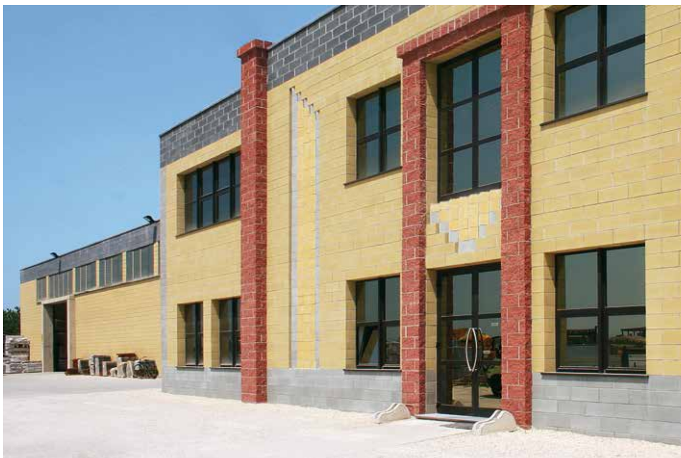
Castelluccio - MN • Azienda Minari • Architettonico Splittato Terra di Siena - Tamponamento Faccia Vista Grigio, Giallo Mori e Antracite
