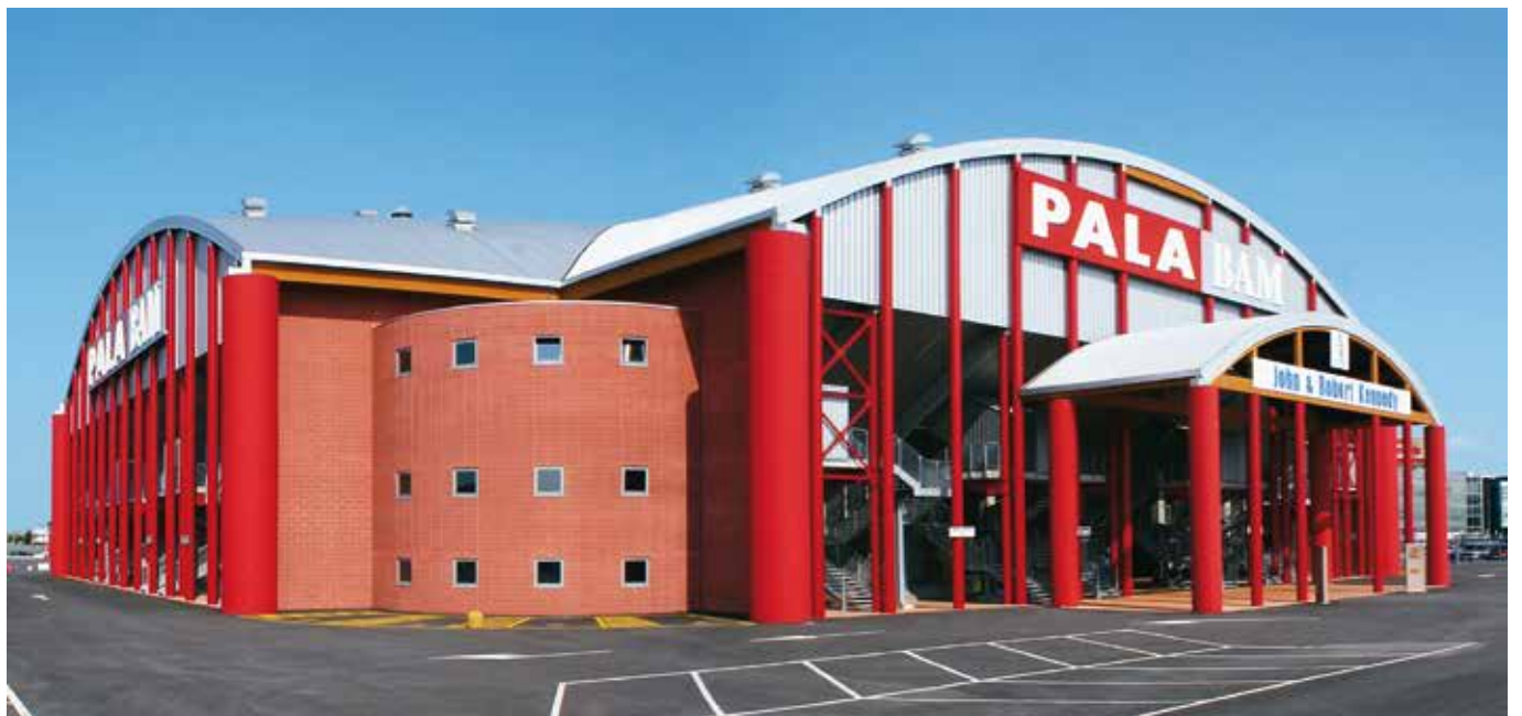
Mantova • Palazzetto dello Sport "PALABAM" • Tamponamento Faccia Vista Rosso Verona
