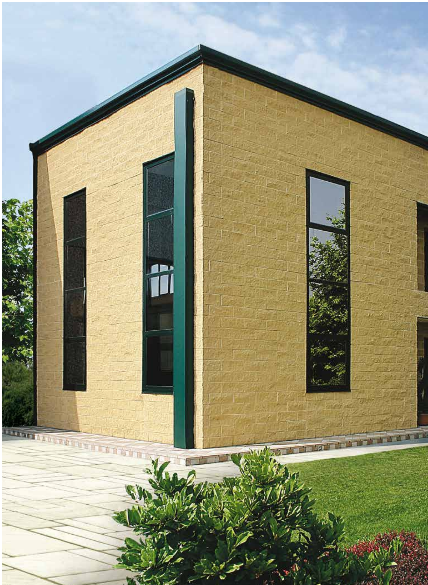
Brandico - BS • Palazzina Uffici Gandellini • Architettonico Splittato Giallo Mori
