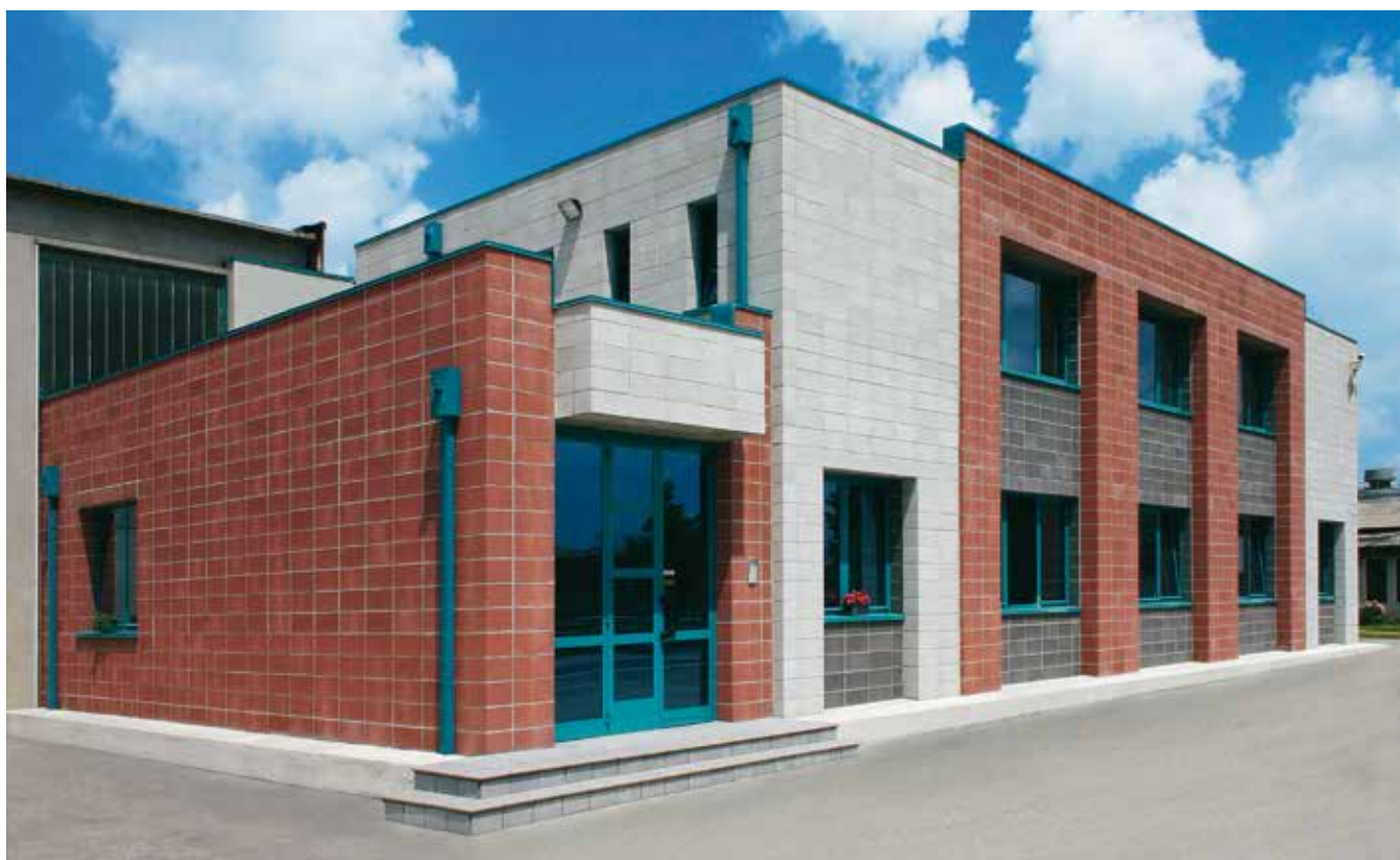
Cento - FE • Palazzina Uffici Lodi • Tamponamento Faccia Vista Rosso Verona, Grigio e Antracite
