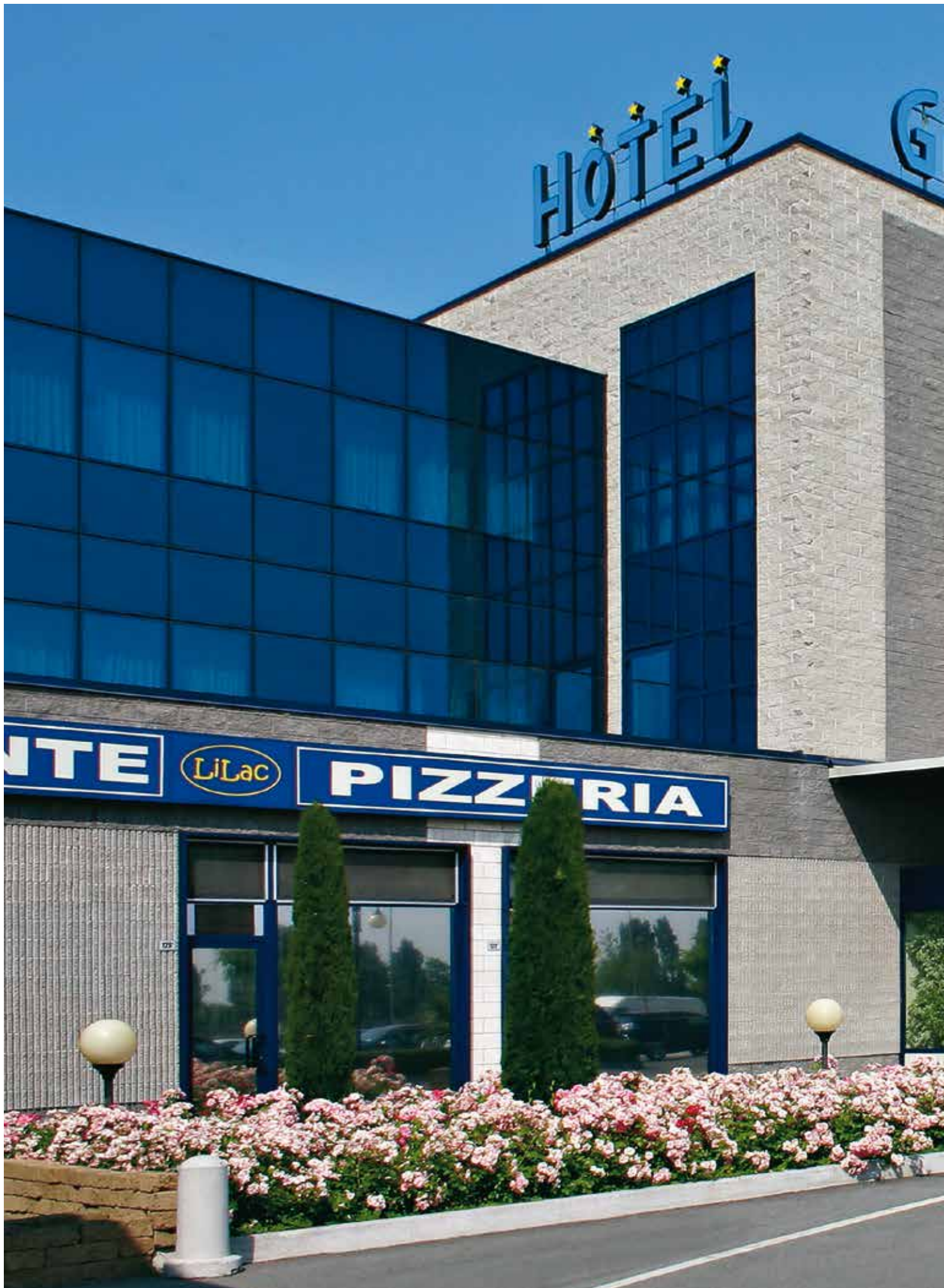
Montichiari - BS • Centro Direzionale Commerciale • Architettonico Splittato Grigio e Antracite - Architettonico Rigato Grigio - Tamponamento Faccia Vista Bianco Botticino
