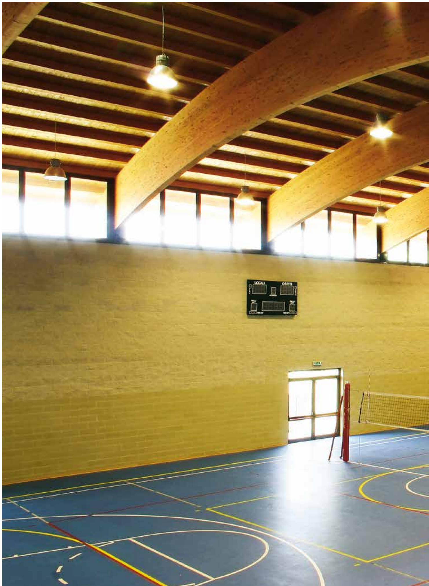
Lazise - VR • Palazzetto dello Sport • Architettonico Splittato in Argilla Giallo Mori - Tamponamento Faccia Vista in Argilla Giallo Mori
