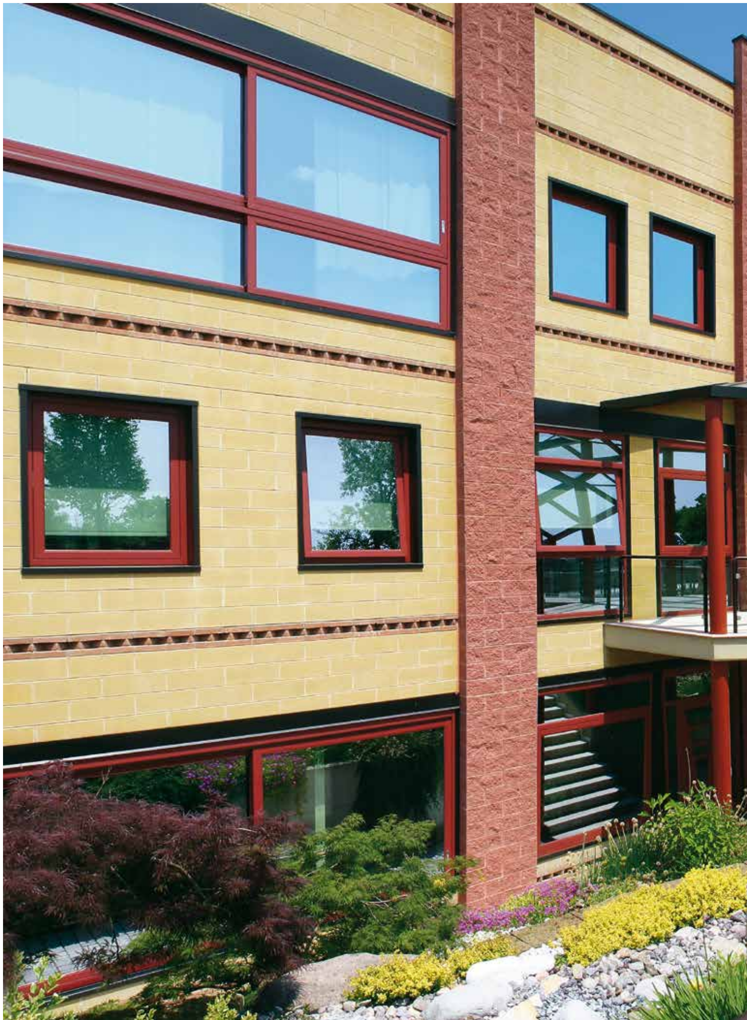
Chiari - BS • Azienda Italserramenti • Architettonico Splittato Rosso Verona - Tamponamento Faccia Vista Giallo Mori
